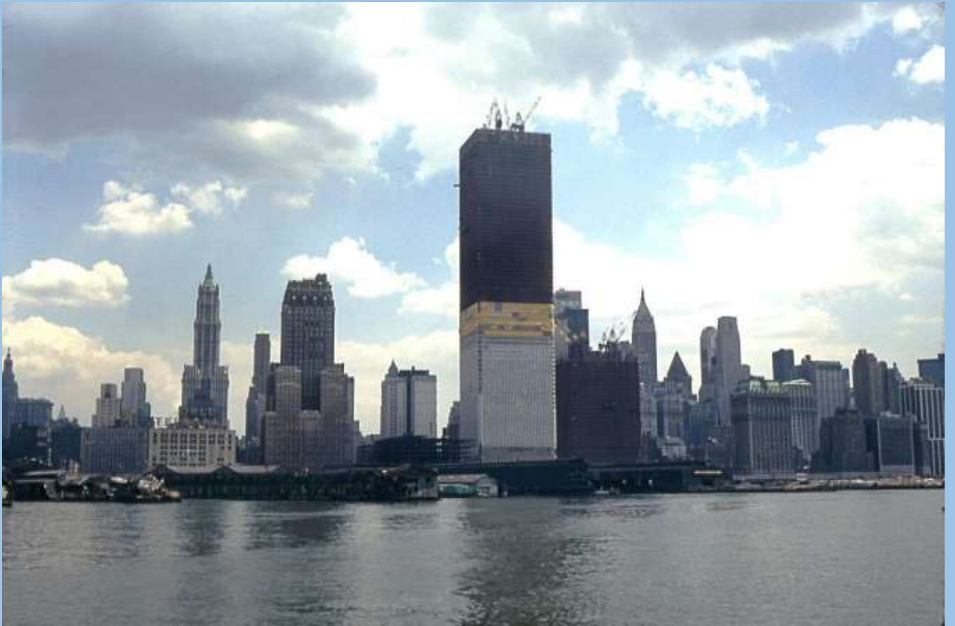
Le World Trade Center en construction
